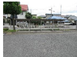
屋根付き駐輪スペース（第1駐車場内）
