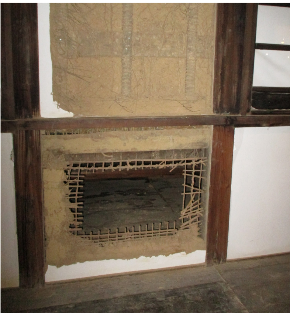
調査実施後の開成館内部の様子
