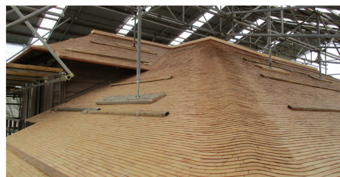
葺き替え中の屋根の様子
