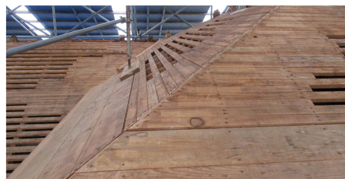
屋根の葺き替え工事の様子
