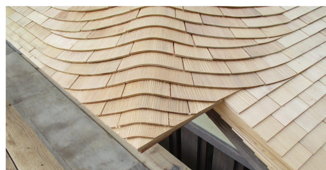
葺き替え中の屋根の様子
