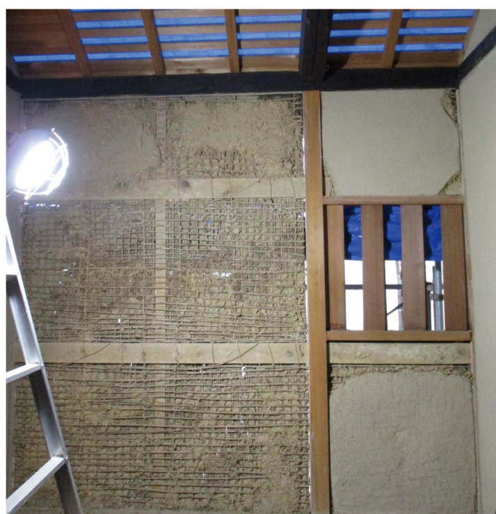
復旧工事の様子
