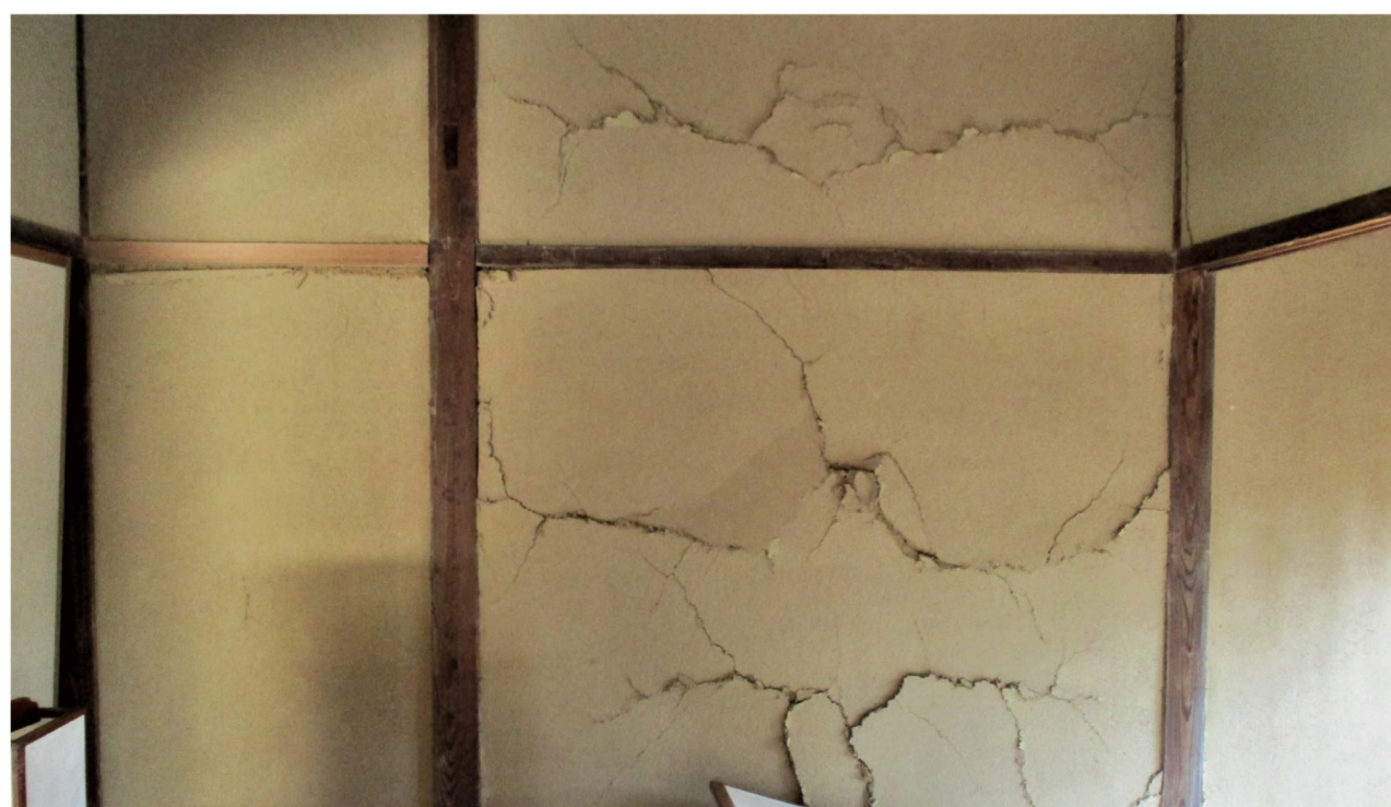
福島県沖地震で被災した安積開拓官舎（旧立岩一郎邸）の様子（玄関の間）
