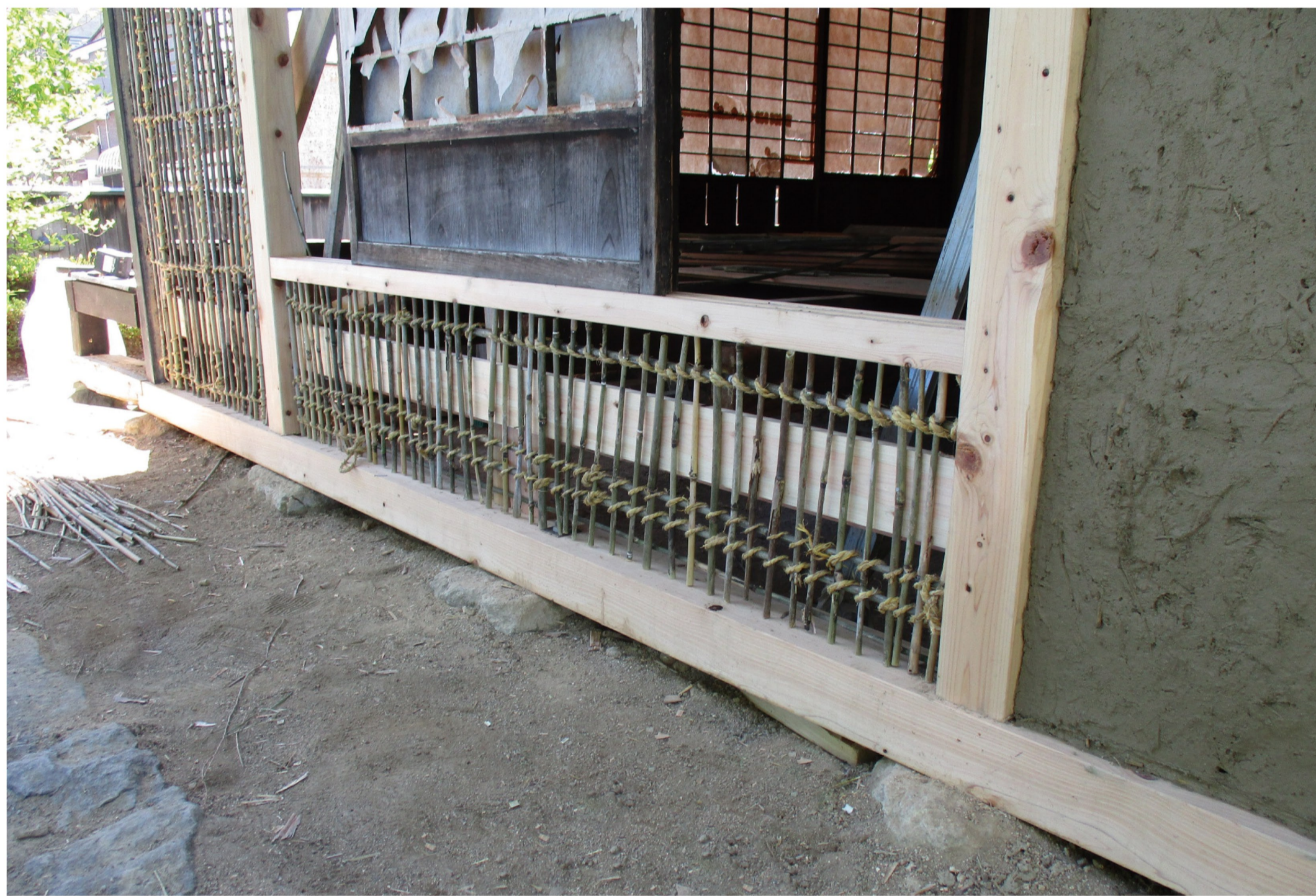
安積開拓入植者住宅(旧小山家)復旧工事の様子(北側)
