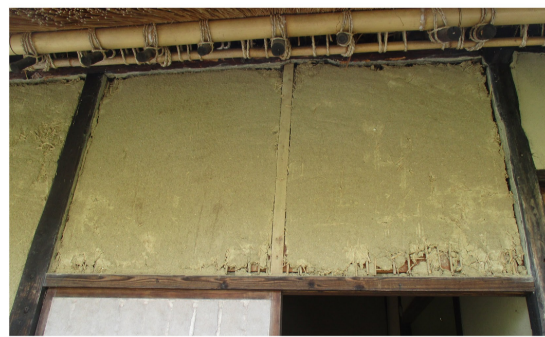
安積開拓入植者住宅(旧小山家)復旧工事の様子(玄関)
