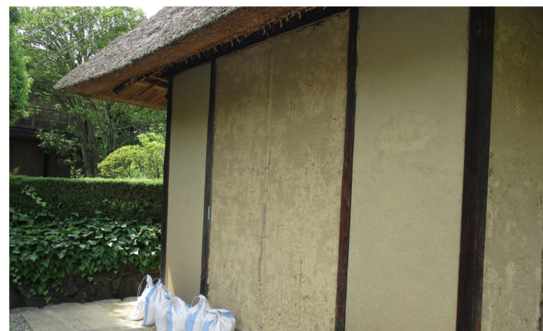
安積開拓入植者住宅(旧小山家)復旧工事の様子(南側)
