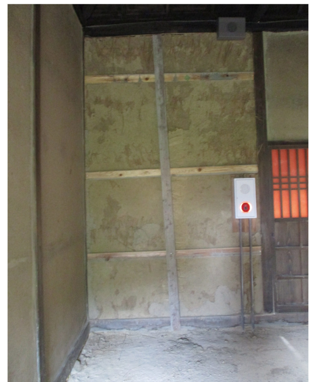
復旧工事の様子(土間)
