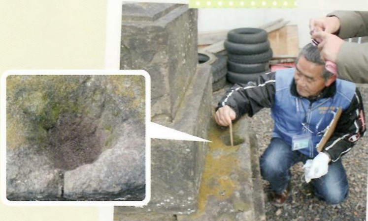
盃状穴作りには、金属の道具が使われたようです。金属痕の縦スジがある盃状穴 直径約10cm まつきいね 松木稲荷神社 (本町二丁目) 常夜燈
